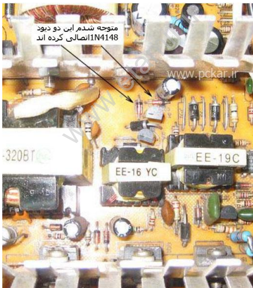
شکل ۲۰،۱۱ - افت ولتاژ خروجی می تواند به خاطر اتصالی دیودهای سیگنالی در بخش ثانویه پیش آید
